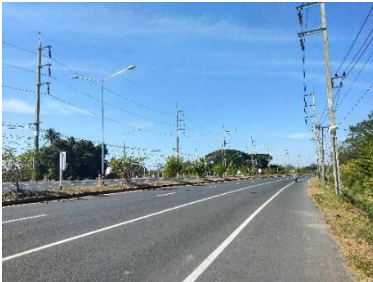
จุดเริ่มต้นโครงการ บริเวณทางหลวงหมายเลข 294 (กม.6+500) ด้านทิศเหนือ
