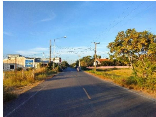
ถนนชุมชนไปบ้านโนนเจริญ
