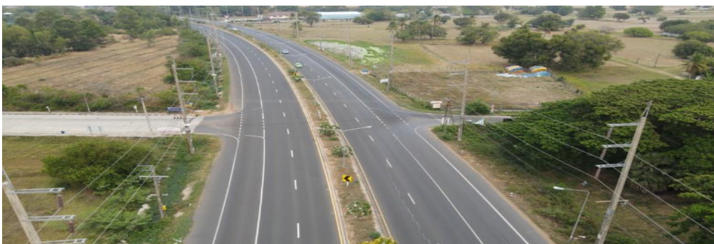
สภาพพื้นที่จุดเริ่มต้นโครงการ บริเวณทางหลวงหมายเลข 294 (กม.6+500)
